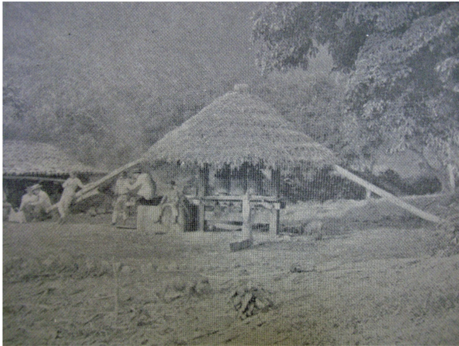
Trapiche de tres mazas verticales. Carúpano Arriba, estado Sucre, Venezuela Fuente: El Cojo Ilustrado , Año VII, No. 162, 1898. p. 645.
