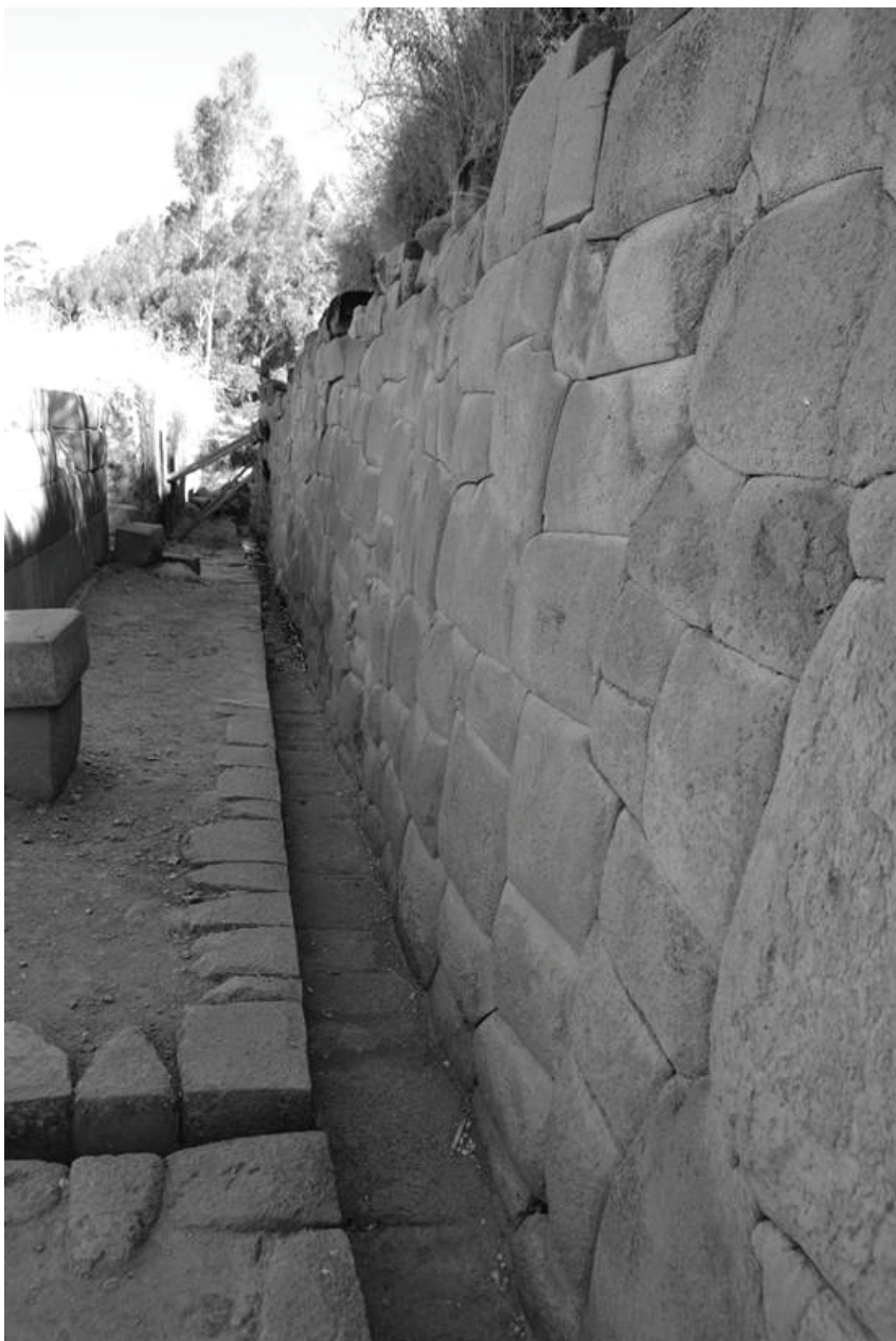
Figura 11. Instalaciones hidráulicas en el denominado palacio inka de Pomacocha (fotografía: Miguel Cornejo).
