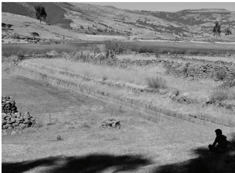
Figura 7. Gran edificio en proceso de construcción a orillas de Laguna de Pomacocha, nótese la técnica constructiva de la primera terraza (fotografía: Miguel Cornejo).
