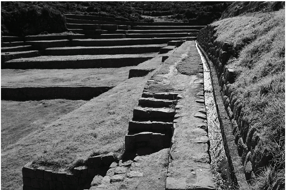
Figura 13. Canal que alimenta varios sistemas de andenes en Tipón, Cusco. Fuente: < http://tiponcusco.blogspot.pe/ >.
