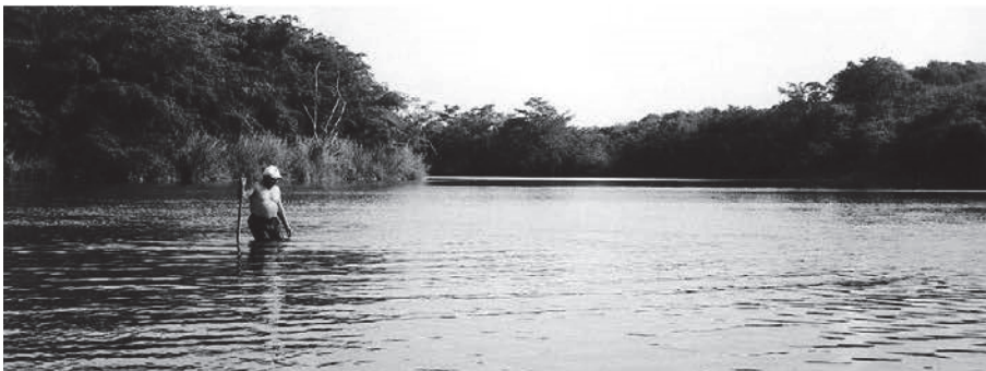
Figura 9. Dique construido en el río Candelaria (A. Soler).
