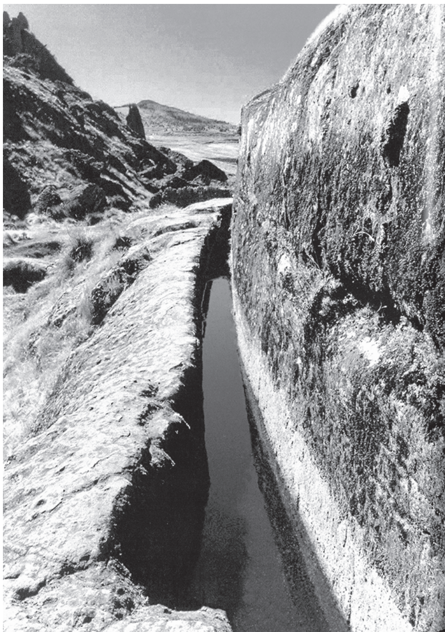
Figura 4. Canal de Cumbemayo, Cajamarca. Tomado de Arquitectura Andina , 2010:118.
