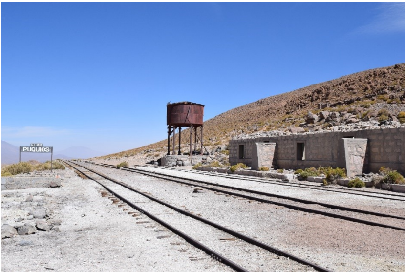
Figura 15. Estación Puquios, campamento minero, centro de procesamiento azufrero y antigua estación de ferrocarril, ramal Ollagüe-Collahuasi (fotografía: Francisco Rivera).
