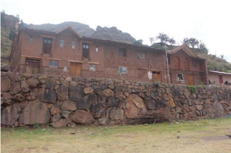
**Figura 5.** Sector Achapata, muro de contención a manera de contrafuerte por la formación antigua de un cono de deyección. Archivo fotográfico personal, 2016.
