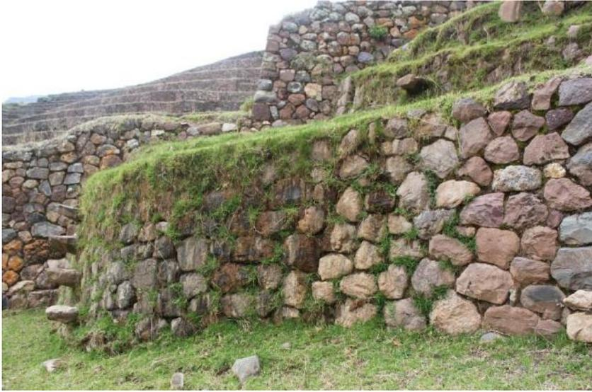
**Figura 10.** Sector Qhosqa, filtración de agua por la obstrucción de los sistemas de drenaje, andén sin uso. Archivo fotográfico personal, 2016.
