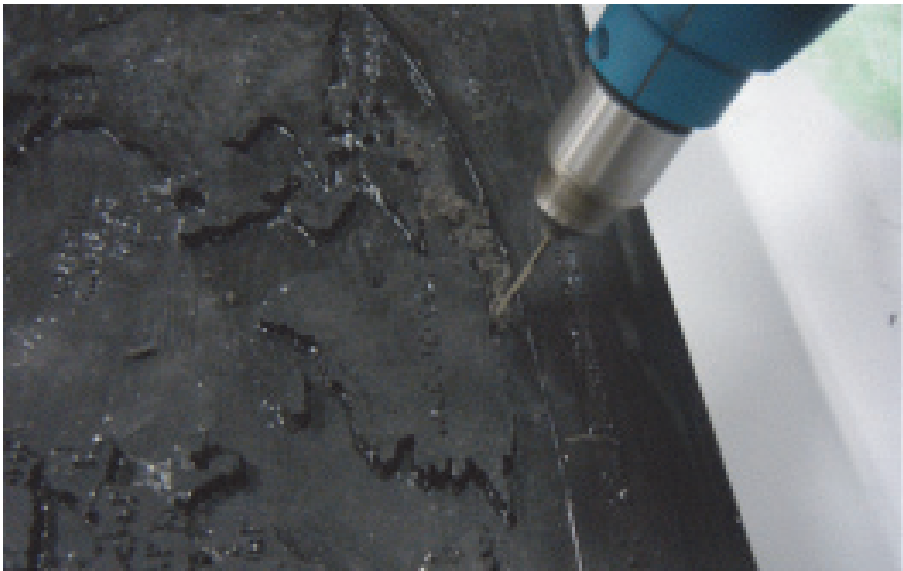
Figura 21 Perforación de orificios para succión de aire.
