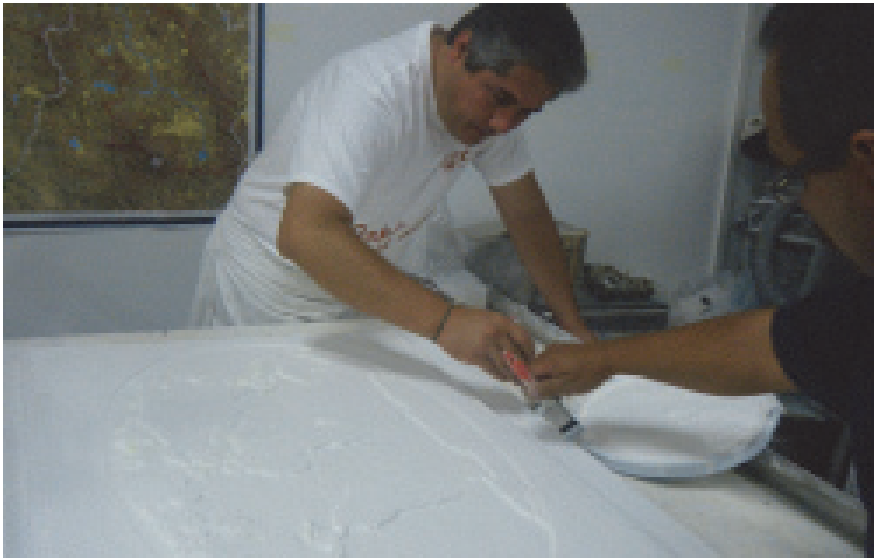
Figura 15. Aplicación de pintura vinilica contramolde.
