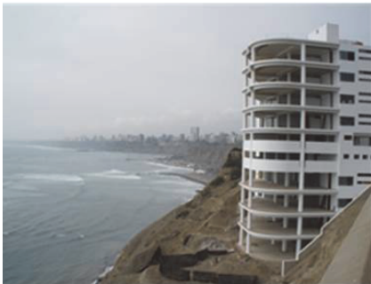
Figura 6. Edificación en los escarpes del Pacífico.
