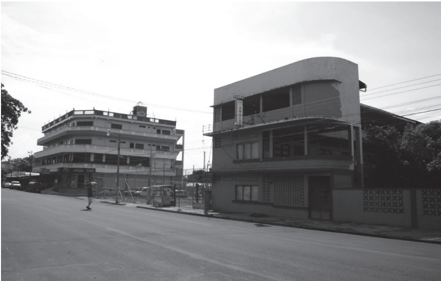
Figura 3. Edificios a lo largo del Paseo de los Turistas en Puntarenas que podrían servir de protección a la población ante un tsunami (cortesía Oscar Sojo).
