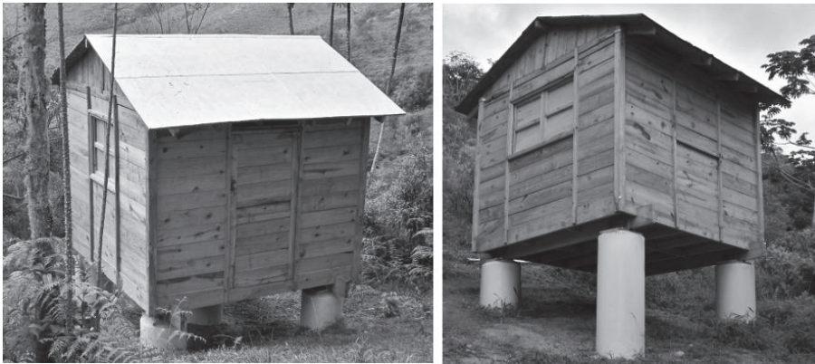
Figura 5. Izquierda: pabellón del variómetro. Derecha: pabellón del magnetómetro escalar con efecto Overhauser. Ambos pabellones de madera son de dimensiones de 3x3m.
