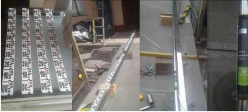
Figura 8. Trabajos previos de preparación del sistema de regla y sensor de presión para la instalación de la estación limnimétrica de Guaqui.
