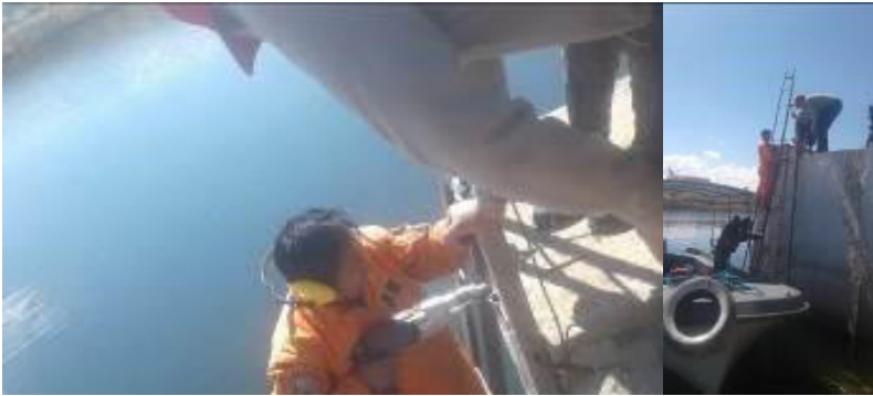
Figura 9. Trabajos de colocación de la regla limnimétrica y del tubo donde se ubicaría el sensor de presión AQUAlogger.
