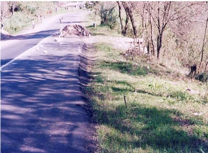
**Figura 2.** Colapso originado en la ruta provincial 305 como consecuencia de la disolución de las formaciones salinas existentes en el subsuelo.
