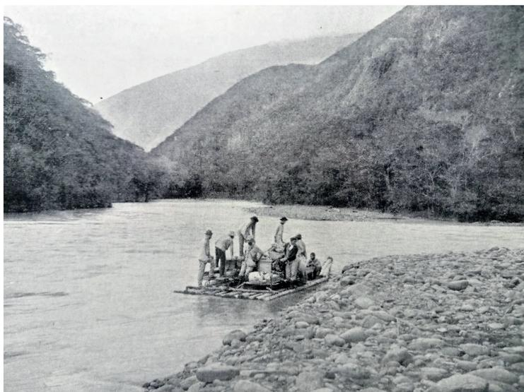
Figura 2. Callapo o balsa, embarcaciones de troncos unidos por amarras, que servían para el transporte.
